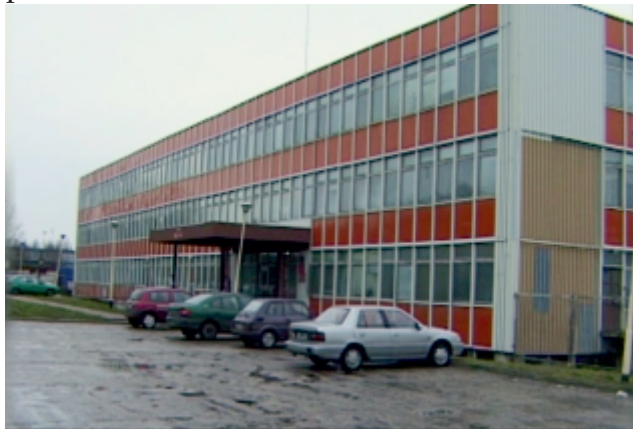
Budynek Starostwa Powiatowego w Policach - 1999 r.
