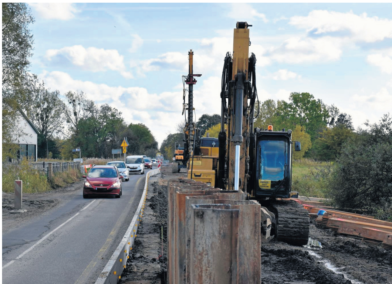
Obecnie prowadzone są prace związane z nabijaniem ścian szczelnych. Równolegle prowadzone są prace przy kanalizacji deszczowej
