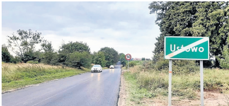
Trwa remont drogi powiatowej Nr 3927Z Szczecin - Siadło Górne
