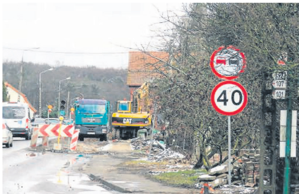
Obecnie na pierwszym odcinku 415 metrów realizowane są prace związane z budową kanalizacji deszczowej i przebudową sieci wodociągowej a także usuwanie kolizji z sieciami infrastruktury
