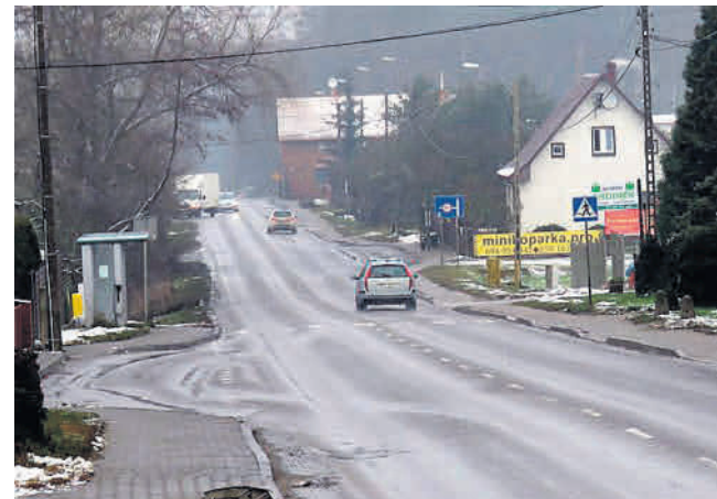
Remont obejmie odcinek przebiegający przez Przęsocin
