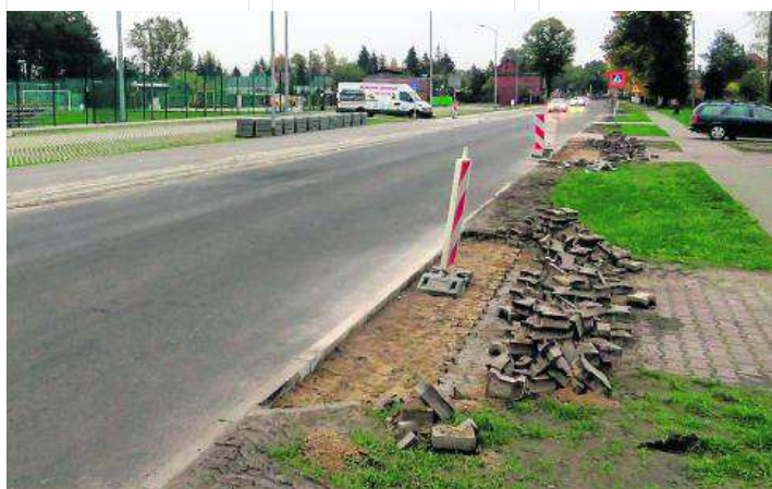
Do końca października warstwa wyrównawcza zostanie ułożona na całej długości drogi
