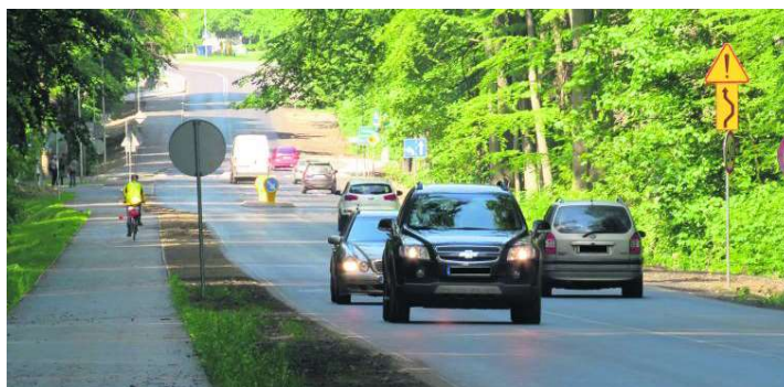
Cała przebudowa drogi obejmuje odcinek długości 4,04 km. Jest realizowana przez Powiat Policki przy współpracy z Gminą Miasto Szczecin.
