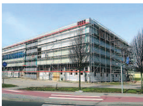
► Robotnicy mają jeszcze pięć miesięcy na zakończenie modernizacji hali przy ul. Siedleckiej
