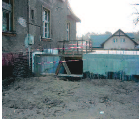
► Do tej pory udało się zakończyć budowę piwnic przyszłego hospicjum
