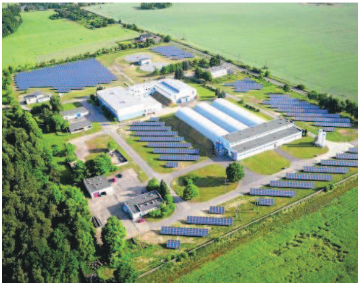
► Tak wygląda farma fotowoltaiczna, która powstała w Zakładzie Produkcji Wody „Miedwie”
