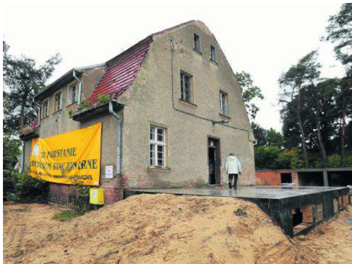
► Fundamenty są już gotowe, czas na poszerzenie budynku
