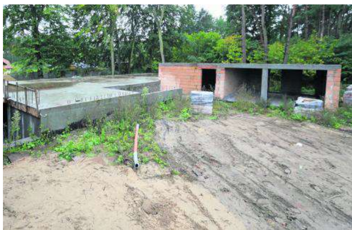
► Tak dziś wygląda część garażowa przyszłego hospicjum
