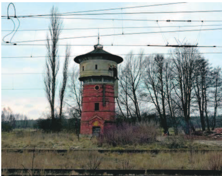
► Na liście Narodowego Instytutu Dziedzictwa znajduje się dworzec kolejowy i wodociągowa wieża
