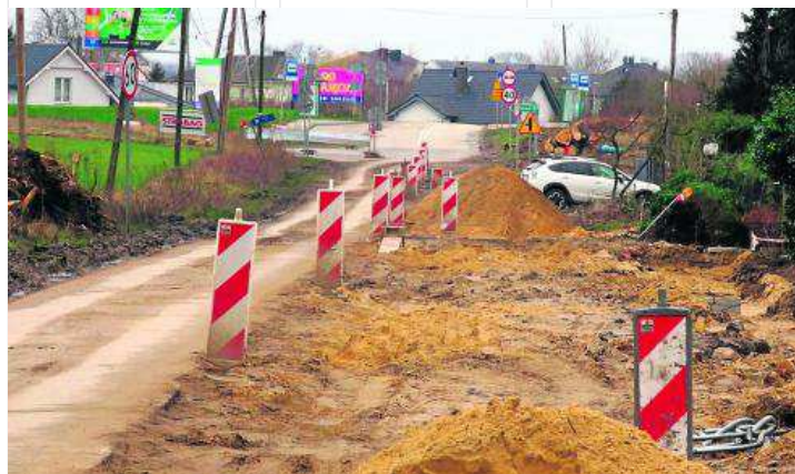
Przypominamy, że obecnie odcinek od Szczecina do skrzyżowania na Rajkowo jest przejezdny tylko dla mieszkańców dojeżdżających do posesji i komunikacji miejskiej
