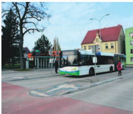
Remont pętli przebiegał sprawnie, choć nie bez niespodzianek
