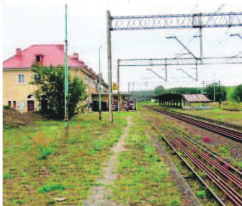
Roboty na odcinku SkolwinPolice ruszą we wrześniu
