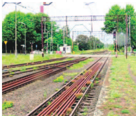
Zgrupowane materiały do budowy nowego toru
