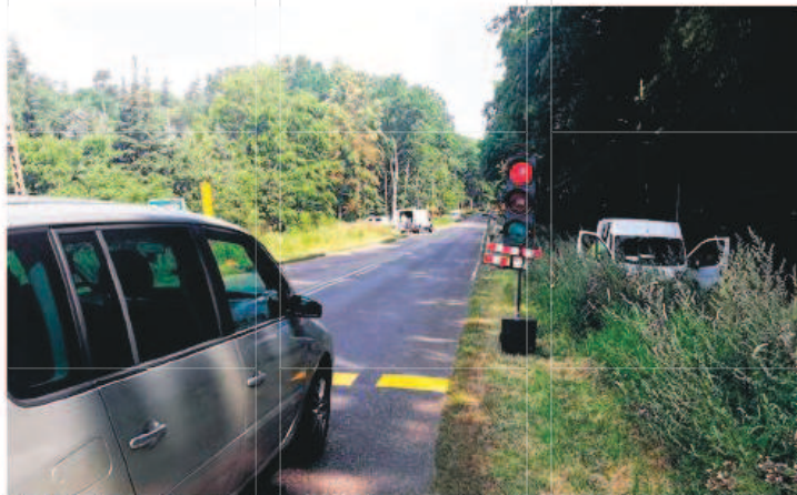
Na placu budowy w Przėsocinie trwa przestój związany z warunkami gruntowymi i zmianami w projekcie
