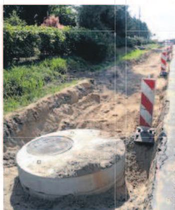
Na ul. Długiej w Mierzynie trwają prace związane z budową kanalizacji deszczowej
