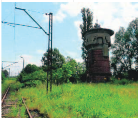
Po dawnej parowozowni pozostała tylko wieża
