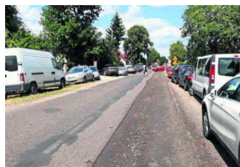
Tak sytuacja wyglądała na początku lipca. W sierpniu kontynuowane będą prace związane z przebudową sieci elektroenergetycznej
