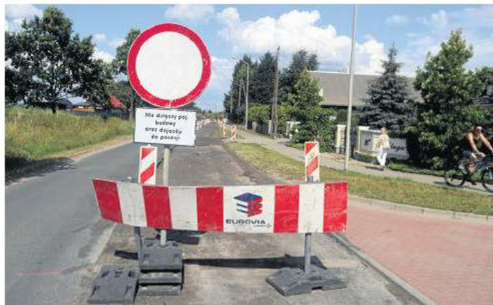
Mieszkańcy Mierzyna widzą pierwsze efekty prac, a także utrudnienia związane z remontem
