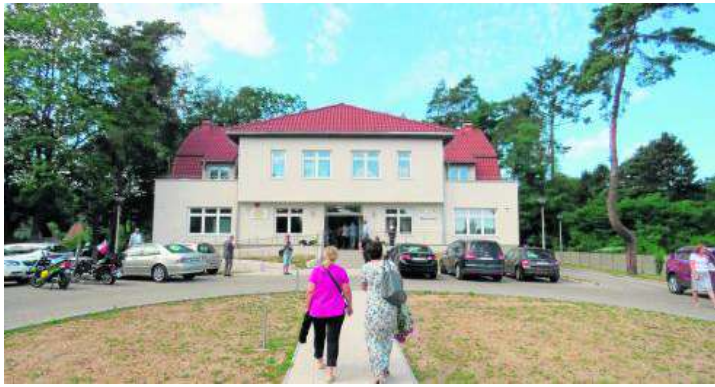
Budowa hospicjum trwała 4 lata i wraz z wyposażeniem kosztowała ponad 7 milionów złotych
