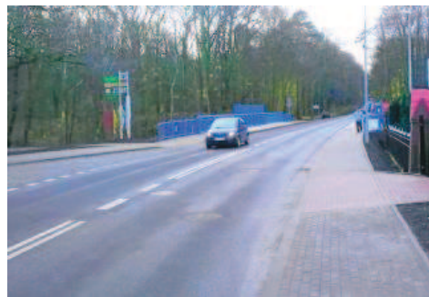
Przebudowa wiaduktu kosztowała 4, 660 mln zł. To był 1. etap realizacji wspólnego zadania powiatu polickiego i Miasta Szczecin
